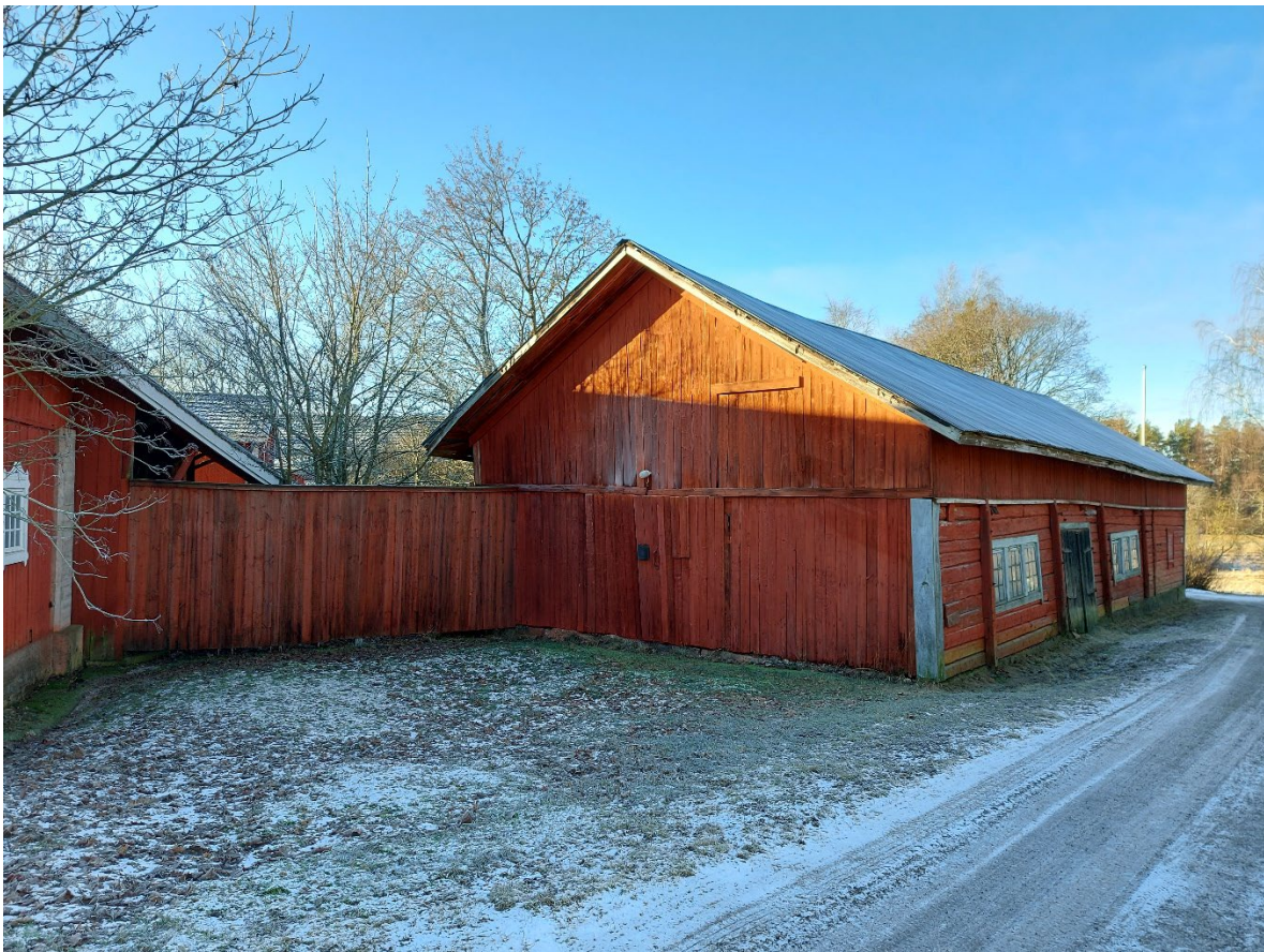
Antintalo ja Kallentalo muodostavat tiiviin ja kansatieteellisesti mielenkiintoisen kokonaisuuden.
